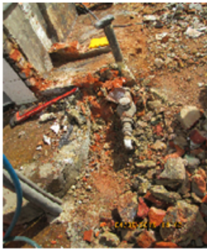
Foto No. 3. Vista del sitio donde se localizaba el medidor.
