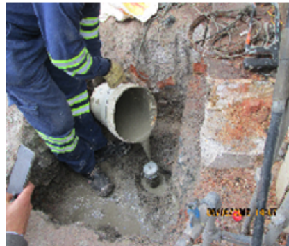
Foto No. 9. Vista de la aplicación de bentonita fluida sobre el espacio intergranular, de la boca del pozo.
