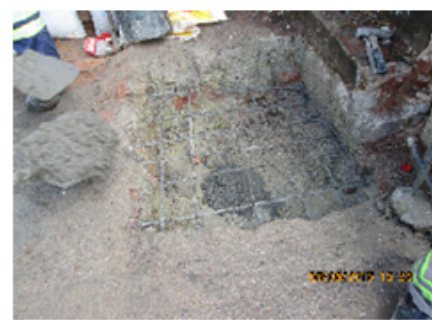
Foto No. 11. Vista de la malla, elaborada en varilla de 3/8.
