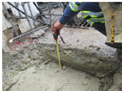
Foto No. 10. Vista de la caja, luego de aplicar dos capas de bentonita húmeda, de 10 cm cada una.
